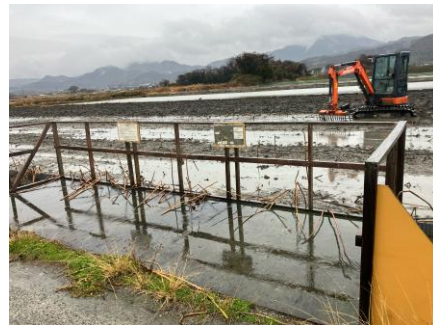
観察用足場 3月30日設置 鳴門市大麻町
