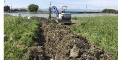
整備工事 4月15日
