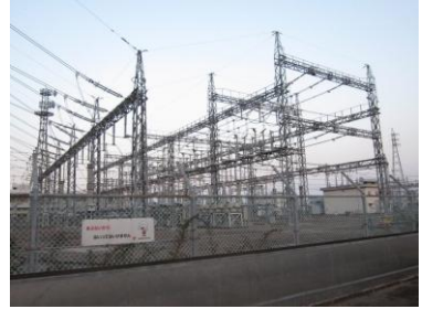
最初に巣作りを始めた変電所 鳴門市大麻町
