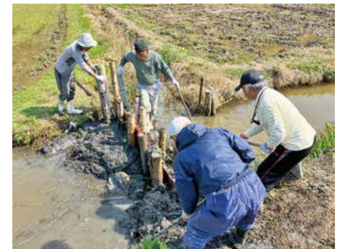
海水の流入を防ぎつつウナギが遡上ができる堰を製作 2025年4月
