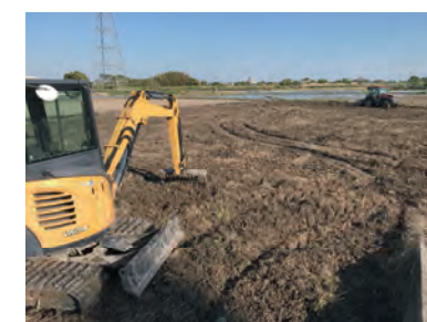
トラクターとバックホーで何度も耕耘、整地
